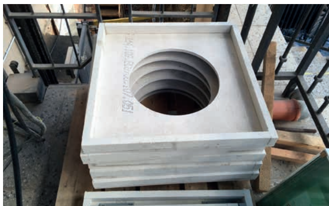
Obruba z desky PROMATECT-H tl. 15 mm s kruhovým výřezem.
